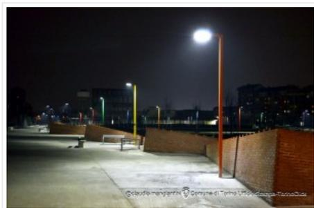
Mediamente dove oggi vi è una lampada a vapori di sodio di potenza 150 watt questa verrà sostituita con un apparecchio a led da circa 72 watt. Le luci avranno un colore lievemente più bianco delle attuali ma grazie al miglior orientamento del fascio luminoso si avrà più luce
